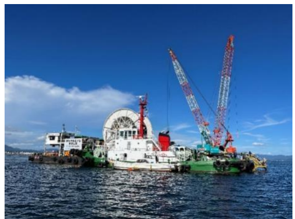
▲海底送水管施工の様子
