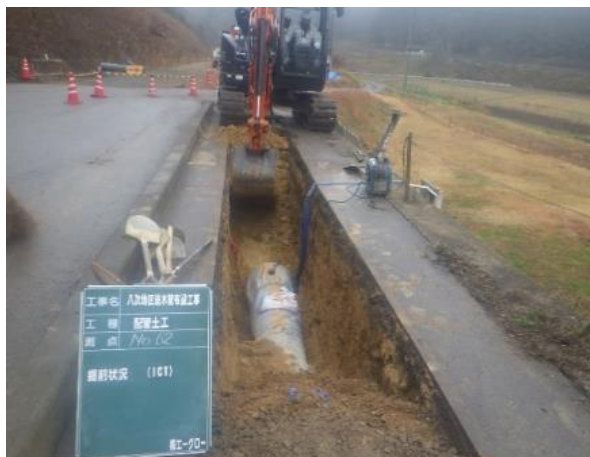
▲管路更新（耐震化）工事の様子
