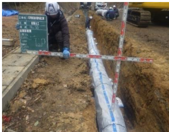
▲管路更新（耐震化）工事の様子
