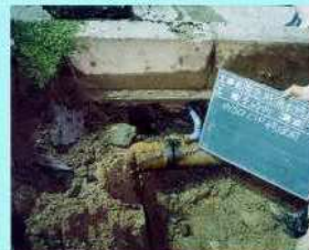
鑄鉄管φ150 継手折れ破損 糸崎町県道糸崎港線
