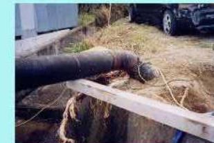
沼田東町釜山 鋼管φ200 継手（溶接箇所）破損
