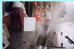
宮沖三丁目 φ13 鋼管 給水管破損
