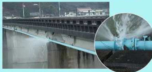
沼田東町本市橋 鋼管φ150 継手離脱
