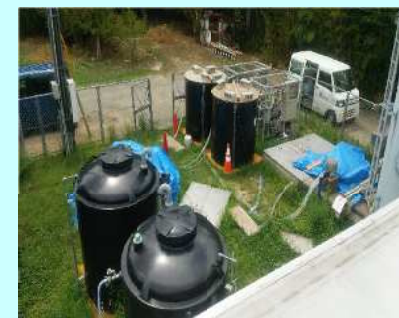
和木浄水場膜ろ過装置
