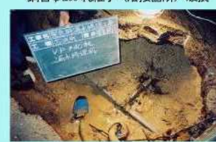
古浜町 φ40 珪ビニール管 給水管破損
