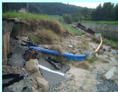
神田橋落橋に伴う水道管破壊状況
