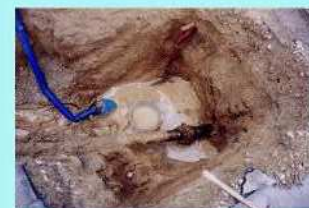
沼田西町 φ75 鑄鉄管 継手離脱
