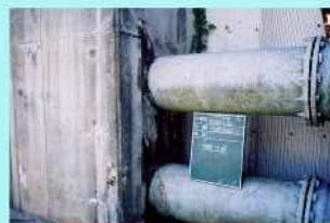
宮浦浄水場 急速ろ過池破損（クラック）
