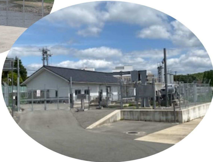
新和木浄水場
