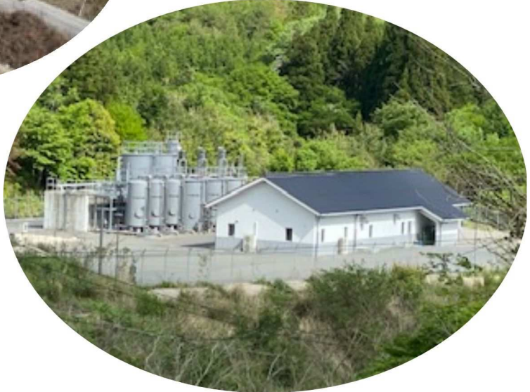
新久井浄水場
