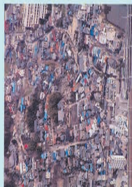
三原町北新付近 ブルーシートで屋根を覆う家屋
