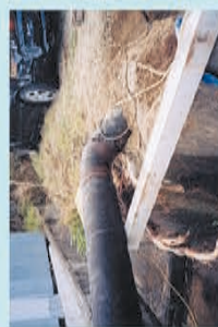
沼田東町釜山 鋼管φ200耗鋼手（溶接箇所）破損
