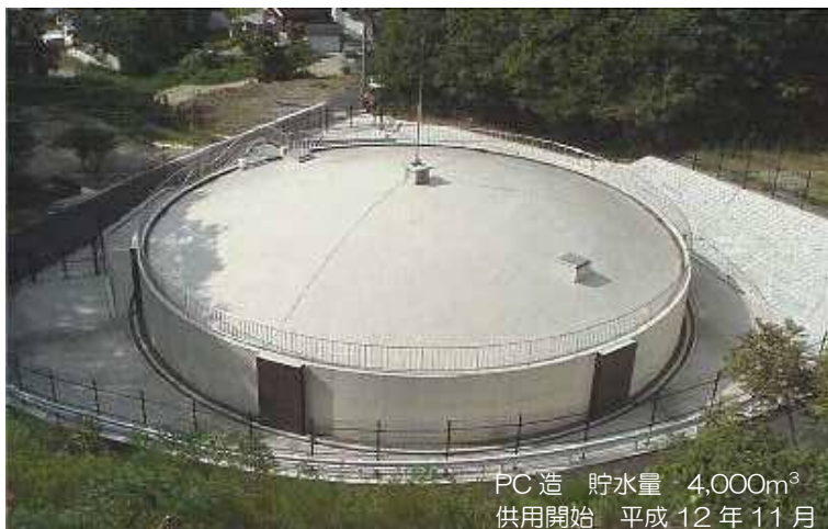
中之町基幹配水池
