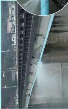
沼田東町本市橋 鋼管φ150 継手離脱
