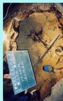
古浜町 φ40 耗ビニール管 給水管破損
