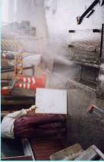
宮沖三丁目 φ13 耗鋼管 給水管破損
