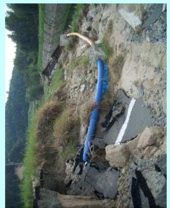
神田橋落橋に伴う水道管破壊状況
