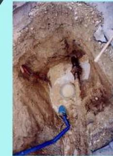
沼田西町 φ75 耗錆鉄管 継手離脱
