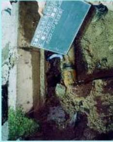
鑄鉄管φ150 耗鋼折れ破損
