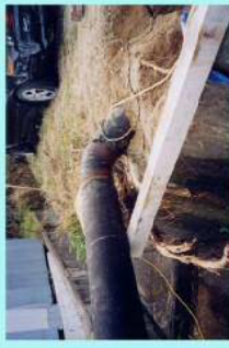
沼田東町釜山 鋼管φ200耗継手（溶接箇所）破損
