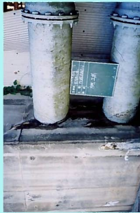
宮浦浄水場 急速ろ過池破損（クラック）
