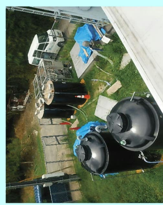
和木浄水場膜ろ過装置
